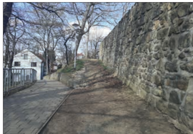
Stávající přístup do prostoru za hradbami přes cizí pozemky a složitou terénní konfigurací.
