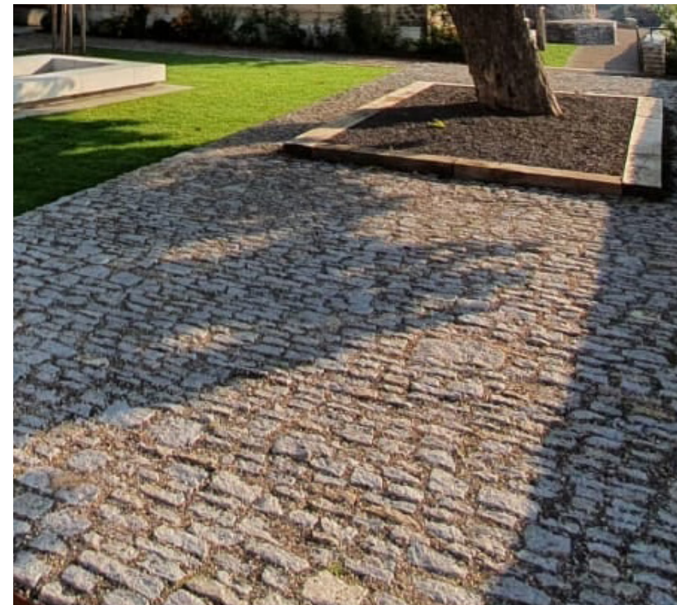
pravidelná kamenná dlažba /v místě parkování automobilů/
